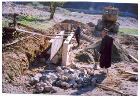
на фото: строительство теплицы в кишлаке Хакими
