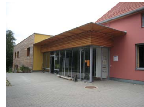
На фото: центральный вход в новый Экологический центр
