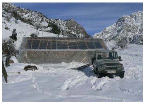
на фото: теплица в Хакими после завершения основных работ
