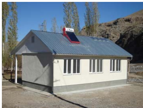
на фото: солнечные панели на крыше ФАПa
