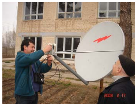
на фото: установка спутниковой антенны для доступа в Интернет
