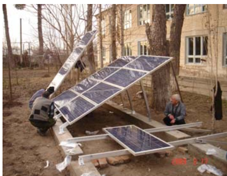
на фото: монтаж солнечных фотопанелей в школе-интернате
