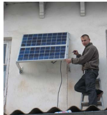
на фото: установка солнечных фотопанелей в офисе организации
