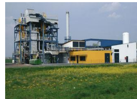
на фото: теплоэлектростанция, работающая на биомассе в Гуссинге
